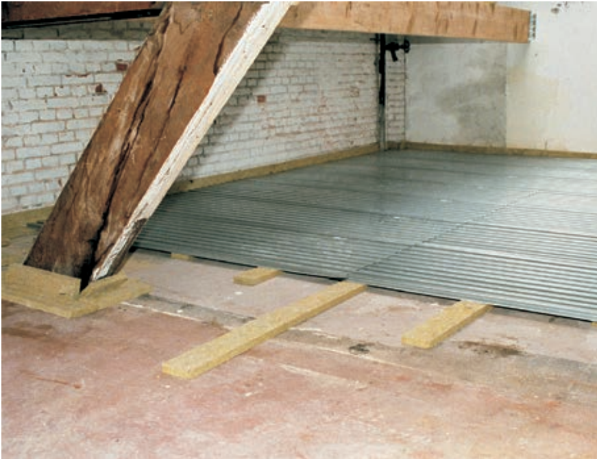
LEWIS®-Schwalbenschwanzplatten verlegt auf mineralischen Luft- und Trittschallstreifen
